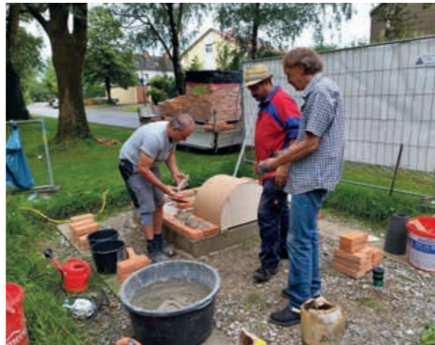
Die tatkräftigen Helfer bei den Mauerarbeiten
