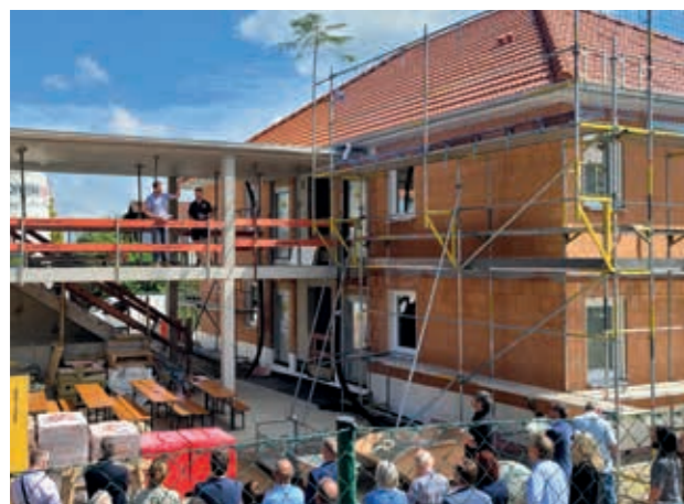
Acht barrierefreie Wohnungen entstehen an der Dorfstraße in Puchheim-Ort.
